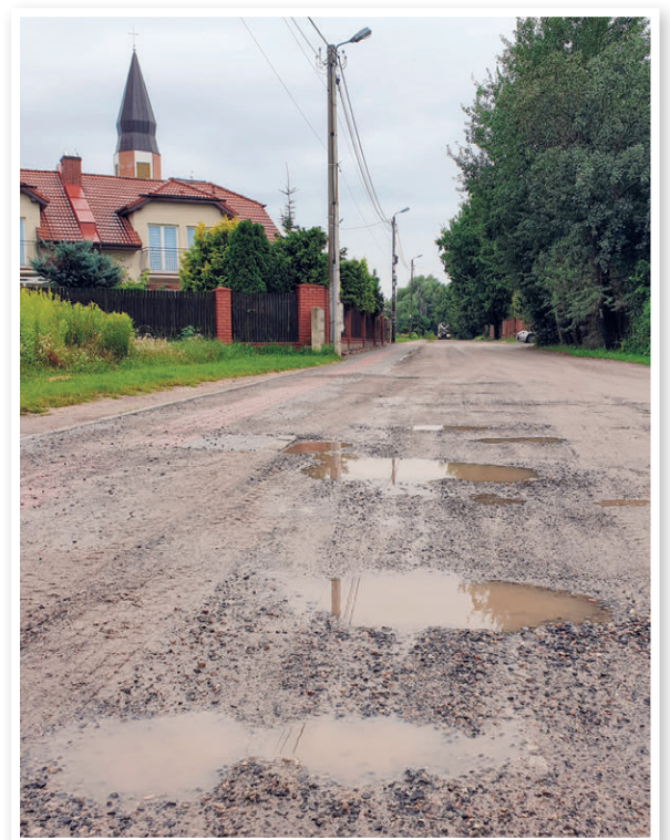
W przyszłym roku Kościelna przestanie być gruntówką.
