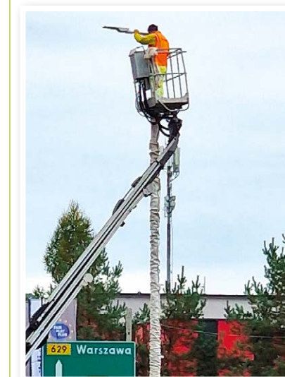
Montaż nowoczesnych latarni w Alei Piłsudskiego.
