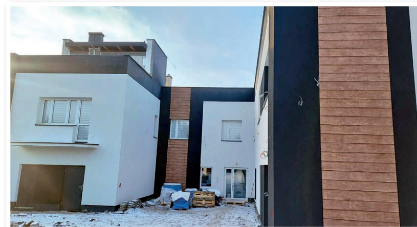
Tak wygląda obecnie budynek przyszłej poradni (koniec listopada 2023 r.)
