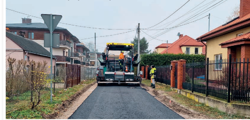
Układanie asfaltu przy ul. Skorupki
