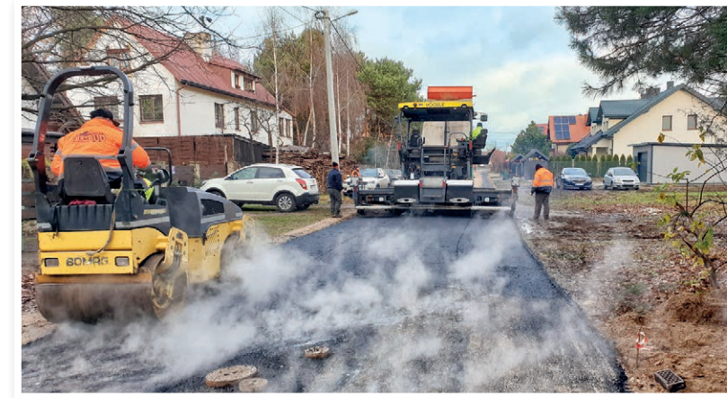
Układanie asfaltu w ulicy Żółkiewskiego.
